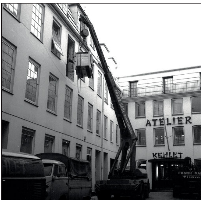
Reimert Kehlet bestilte to Pako Prossere i USA. Her er den første netop ankommet til Købmagergade. Trapperne i de gamle ejendomme var alt for smalle til, at de tonstunge maskiner kunne bæres op. I stedet blev et vindue og et stort murstykke fjernet og ved hjælp af en kran blev den første maskine løftet ind gennem muråbningen.
