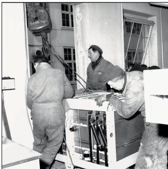
De dygtige transportfolk har fået fremkaldemaskinen ind gennem muråbningen. Det ses tydeligt, at fremkaldemaskinen består af et gråmalet stel af rustfrit stål. I stellet står de modulopbyggede tanke. Alle Pako tanke er udført i austenitisk syrefast stål, som kan modstå angreb fra blegbade og blegfixerbade.
