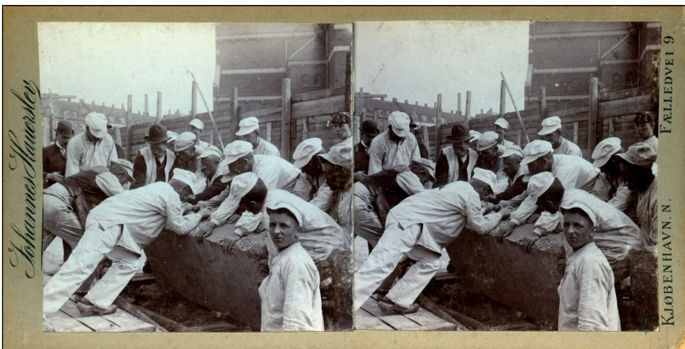
Johannes Hauerslev har taget utallige fotografier af arbejdssituationer. Her en gruppe murere (arbejdsmand?) med hvad der formentlig er fundamentet til et større hus. Baggrunden kan tolkes som et typisk Københavnsk brokvarter.
