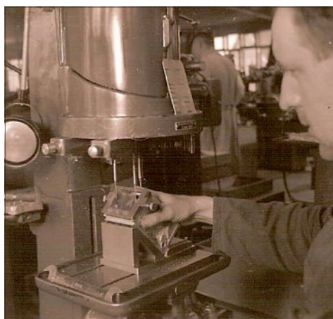
Flerspindellet boremaskine
