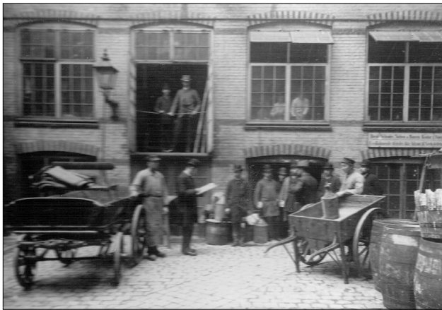
Der gives besked på arbejdet
