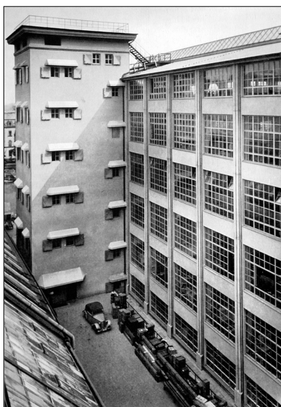
Zeiss Ikon's trappetårn udført som beskyttelsesrum
