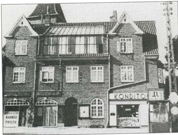
Den statelige rødstensbygning med 'drivhuset'.
