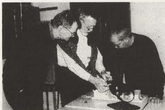
Lukkertiden på Sven Dahls Minolta kontrolleres af Svend Frederiksen på sit måleapparat.
