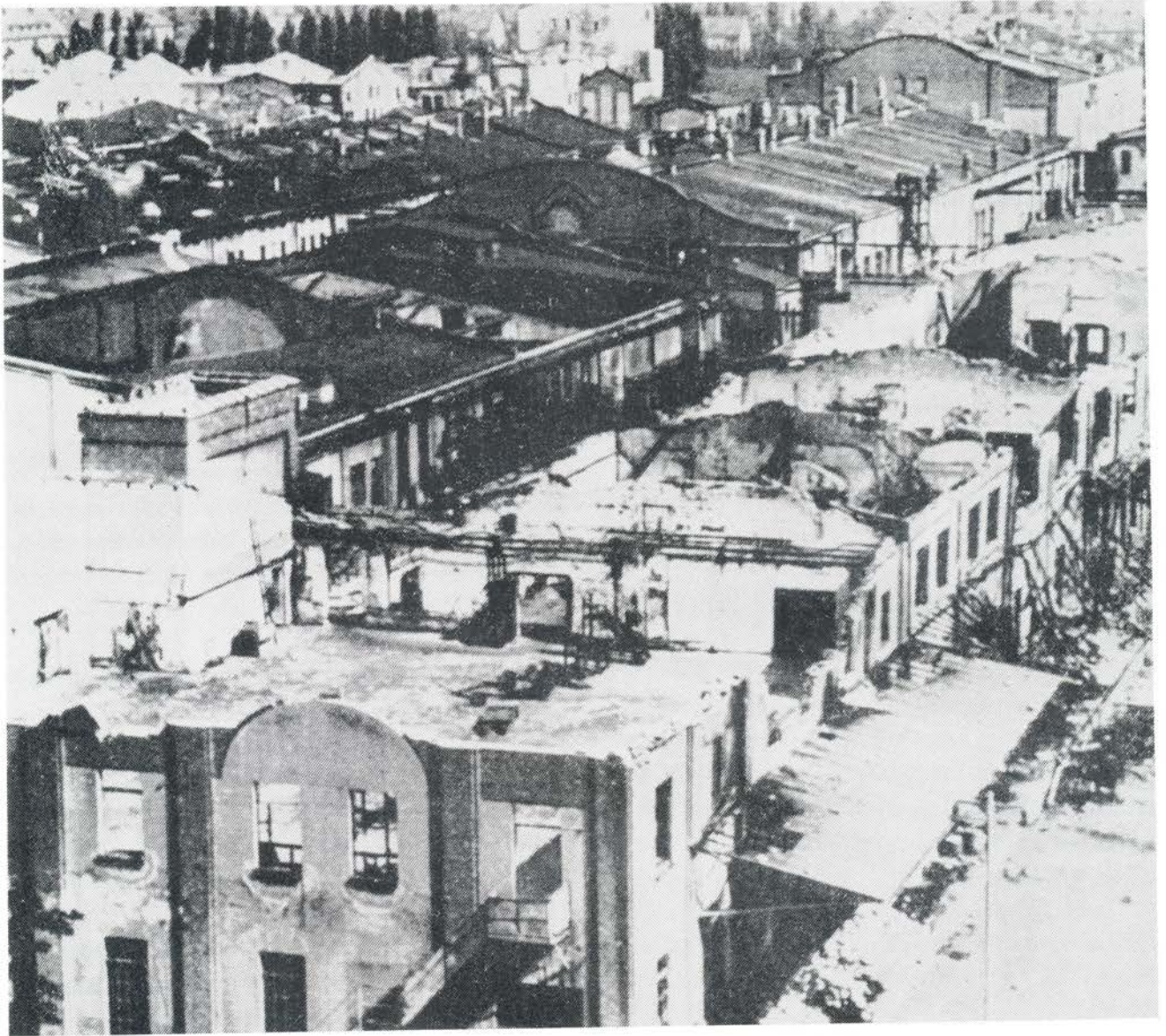
I dagene 15. til 18. april bliver 14% af fabriksbygningerne lagt i ruiner.
