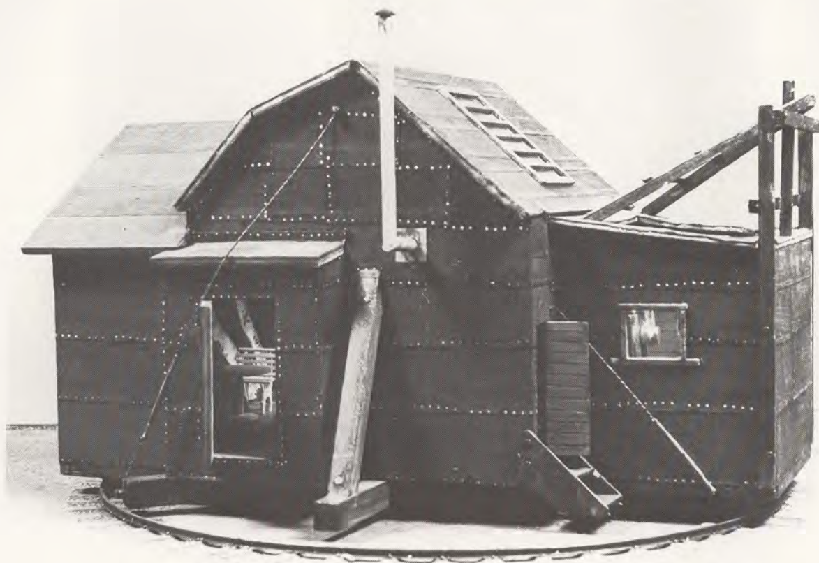
Verdens første film-atelier "Sorte Marie", bygget i 1893. Konstruktionen var drejelig for at opfange optimalt sollys. Pris 637,65 dollars!
