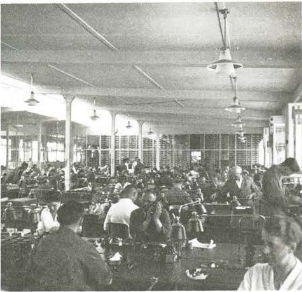
Finmekanisk montage af kamerahuse.
