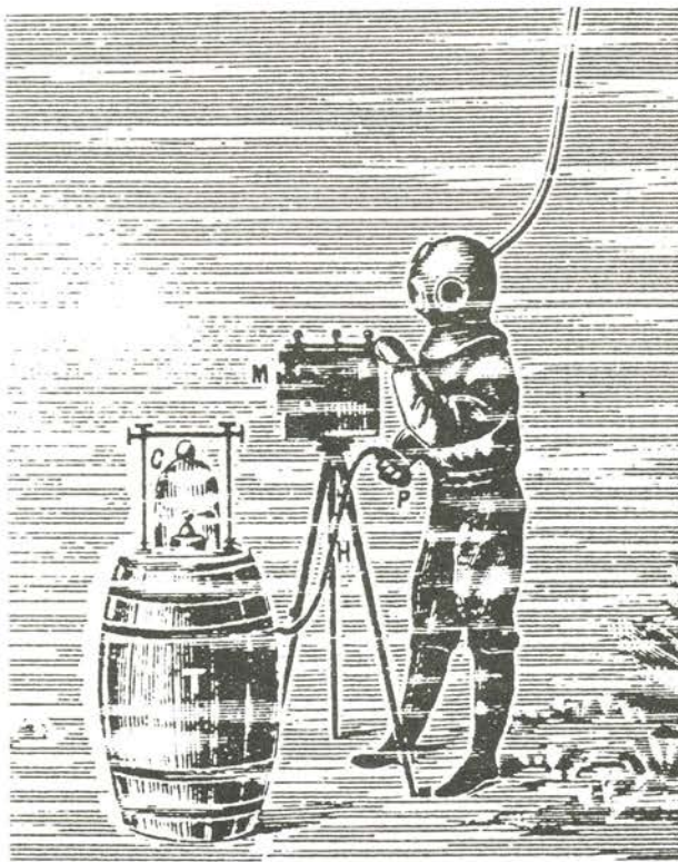
Undervandsfotografering af L. Boutan. Magnesium forbrændes i en lukket ilt-atmosfære.
