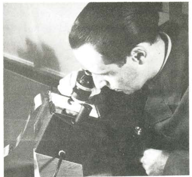
Prøveoptagelser af testvæg undersøges for at kontrollere optik og kamera.
