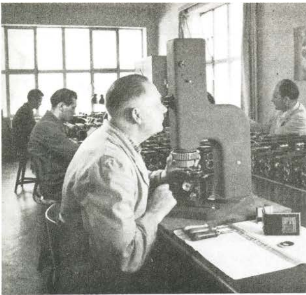
Objektivjustering i en autokollimator.
