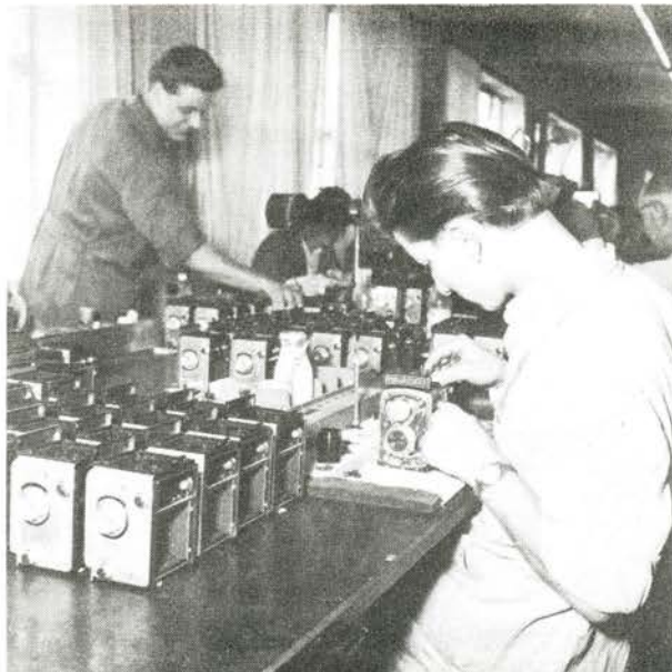
Finmekanisk montage af dele i søgeren.
