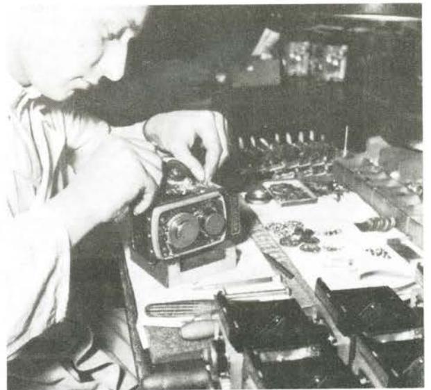
Montage af optrækket i en Rolleiflex.
