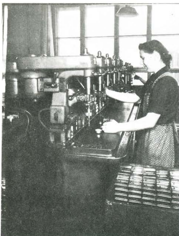
Rækkeboremaskine, hvor emner lægges i et borefixtur og får boret forskellige huller.
