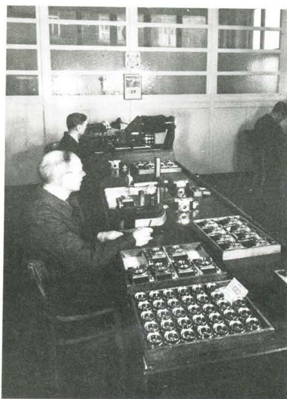
Forrest kontrolleres frontens parallelitet med filmplan på et parti Prominent I. En bakke med Nokton 1,5/50 i forgrunden. Bagest kontrolleres for focusfejl i en kolimator.
