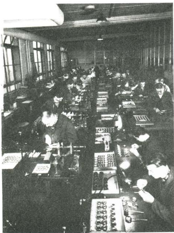
Optisk værksted hvor linseelementerne samles i fatninger.
