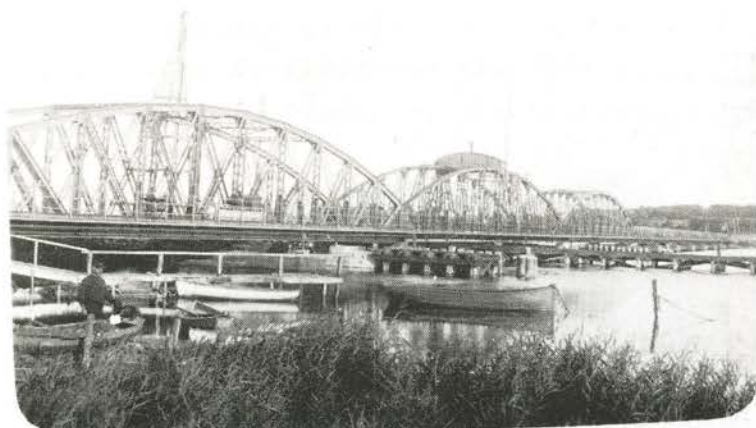
Hadsundbroen 1934. Udskiftning af svingpartiet. Foto: M.P.
